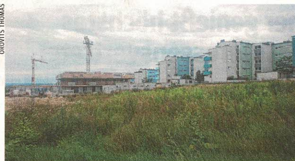
Der neue Stadtteil Kirchäcker soll einen Park bekommen
